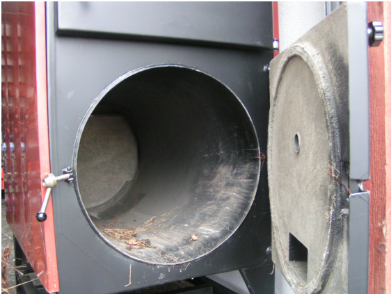
Kocioł z paleniskiem walcowym i spalaniem z ciągiem naturalnym
