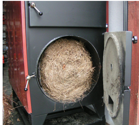
Kocioł z paleniskiem walcowym i spalaniem z ciągiem naturalnym
